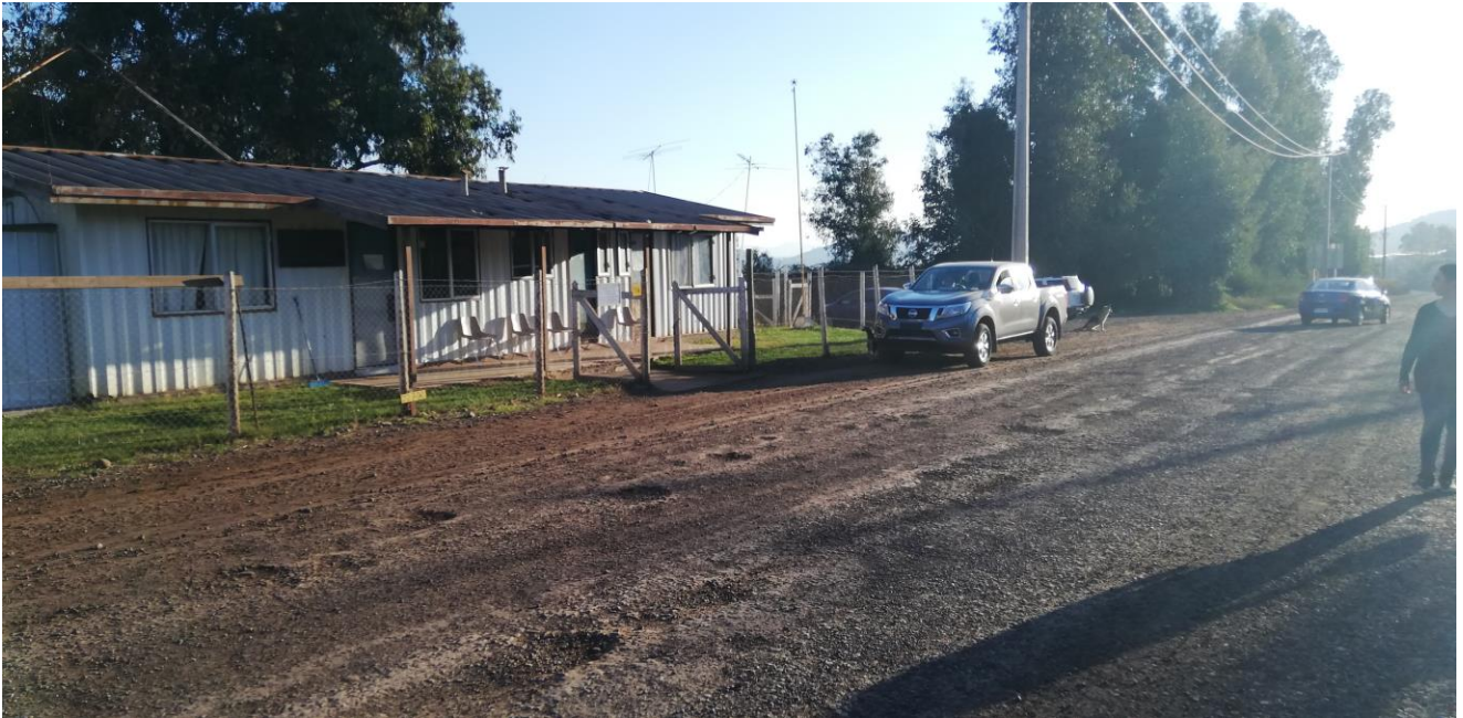
Poste punto de conexión
