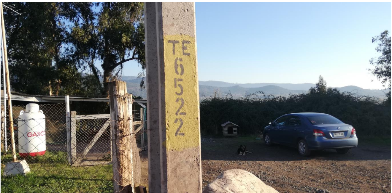
N° placa TE 6522 Poste punto de conexión
