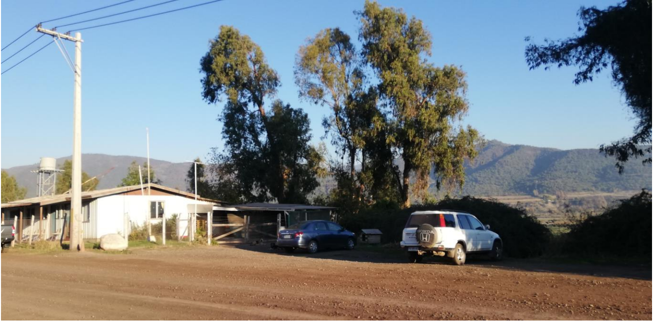
Poste punto de conexión
