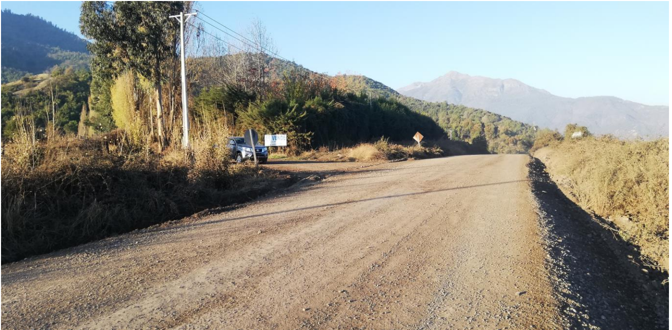
Poste punto de conexión
