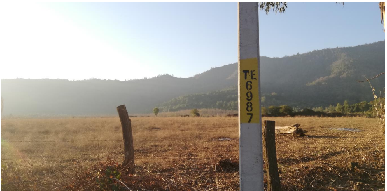
N° placa TE 6987 Poste punto de conexión
