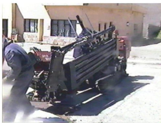
Figura 1: Equipo dirigible utilizado en obra.
