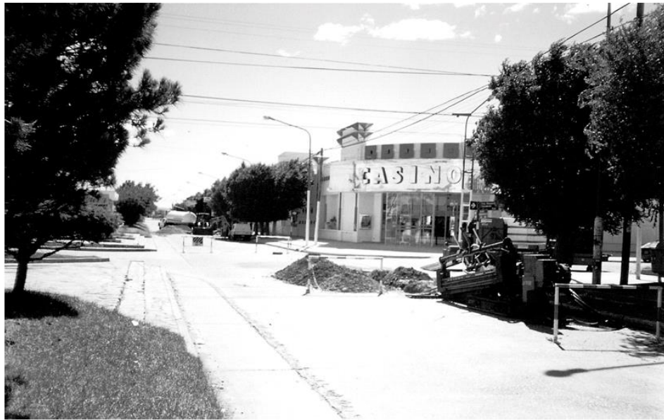
Figura 5: Ejemplo de la máquina frente a la ventana de intervención.
